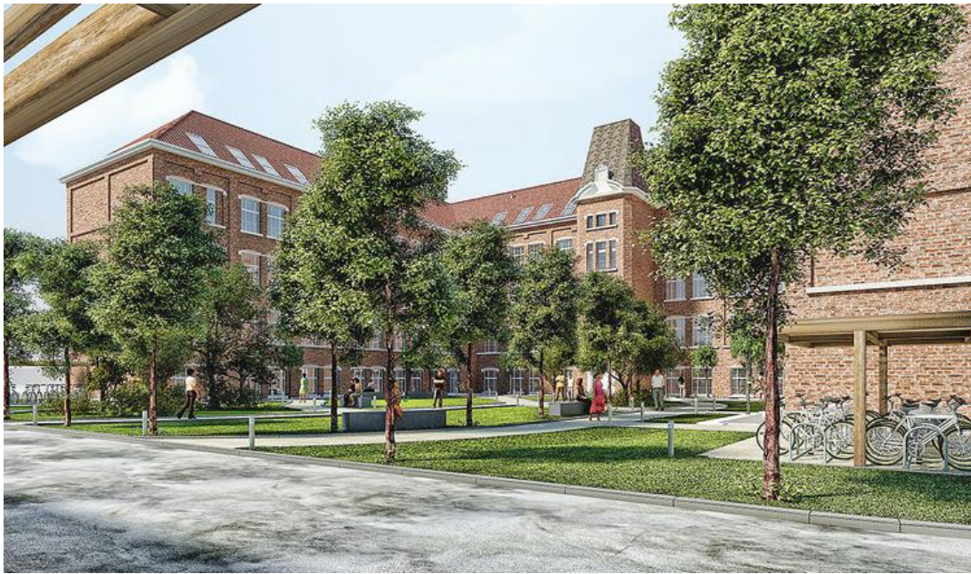
Parmi les projets de Vicinity, il y a la Chemiserie, 66 logements à Molenbeek, en phase d'achèvement.
